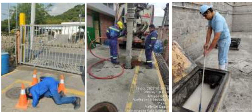
Ilustración 57. Limpieza de tuberías, trampas de grasa y pozo séptico
